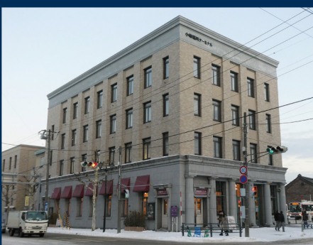
北海道中央バス第二ビル改修(小樽市)
