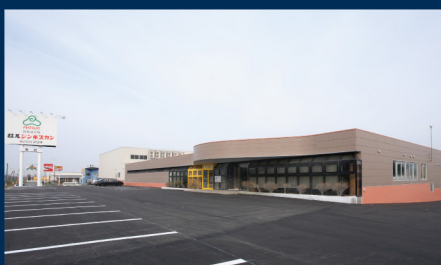
松尾ジンギスカン本社・工場(滝川市)
